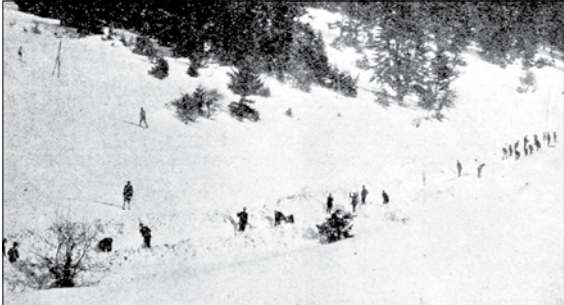
Χειμώνας της δεκαετίας του 1920. Εργάτες με φυτάρια «ανοίγουν» το δρόμο στο διάσελο της Αλωνίσταινας
