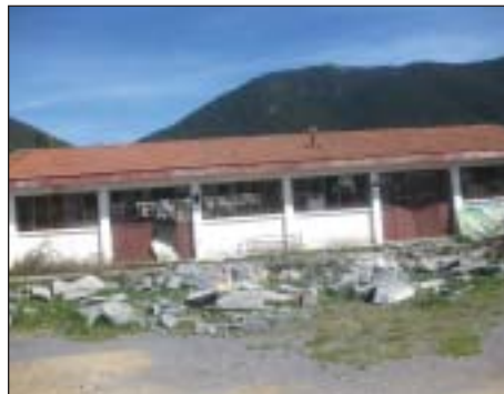
Η εικόνα ερείπωσης των κτιρίων των κατασκευαστών
