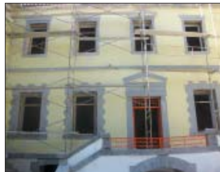
Το κτίριο της Τριανταφυλλιδείου σχολής στην τελευταία φάση εργασιών συντήρησης
