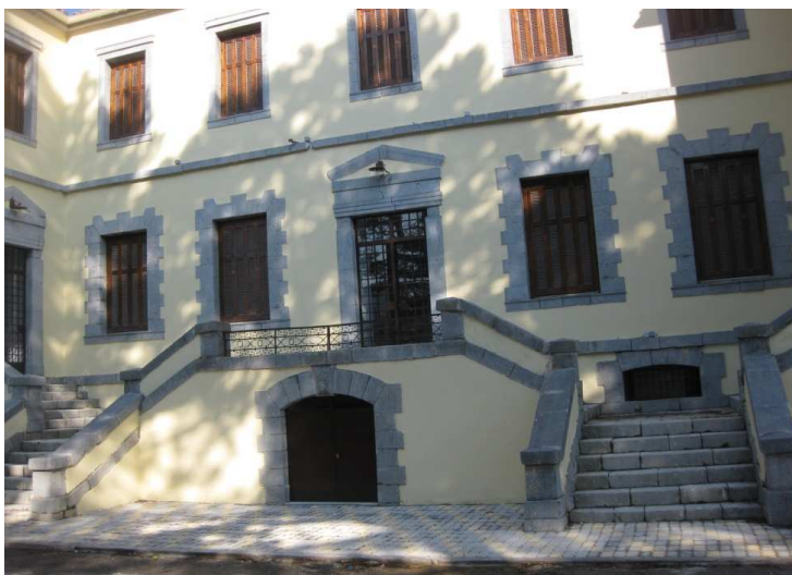
Το ανακαινισμένο κτίριο της Τριανταφυλλιδείου σχολής που μπορεί να στεγάσει δωρεάν το κέντρο μεσογειακής διατροφής.
